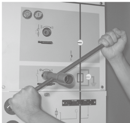
2. 顺时针扳动操作手柄，则接地开关合闸。
