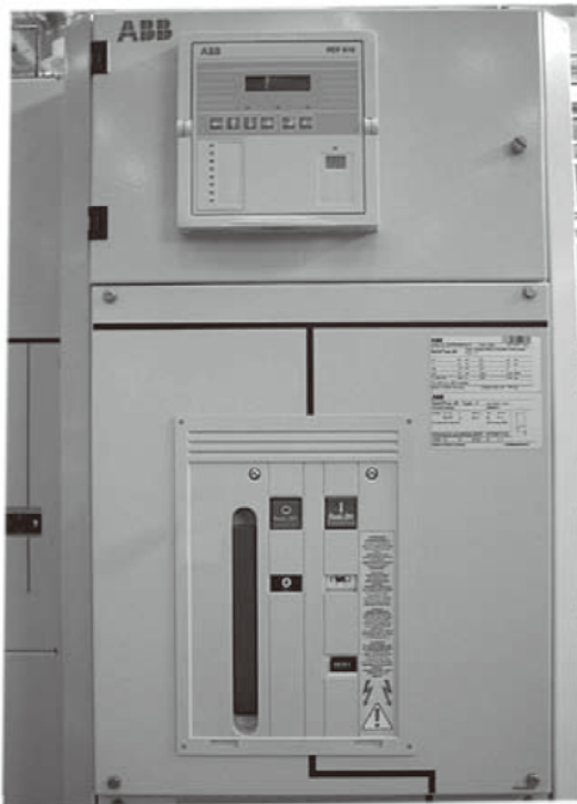
集成低压室（带有铰接门），配置保护继电器的V模块。
