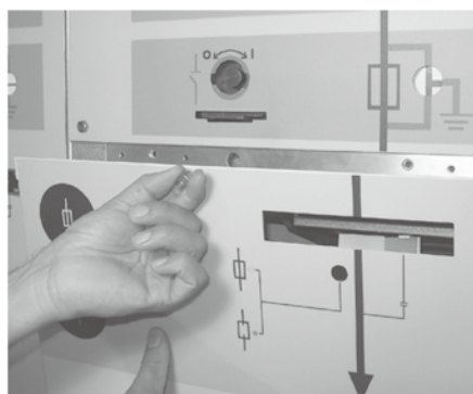
3. 逆时针旋转捏把，斜向打开前面板，露出里面的熔断器筒。
