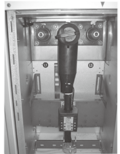
V模块电缆室 以及电流互感器和固定电缆的安装板
