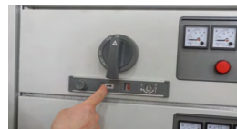
将移动钮左拨，闭锁解锁钮和摇杆孔
